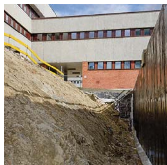
Bezpieczne nachylenie skarp wykopu.
