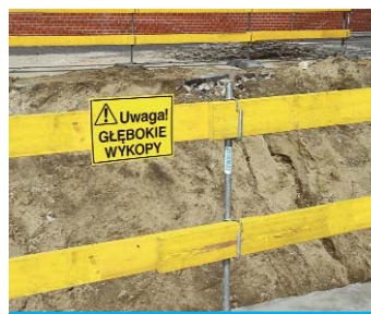
Zabezpieczenie krawędzi wykopu.
