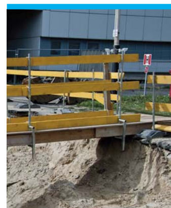
Przeście nad wykopem musi być zabezpieczone balustradami.
