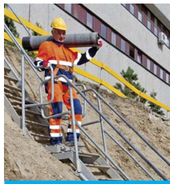
Bezpieczne zejście do wykopu.
