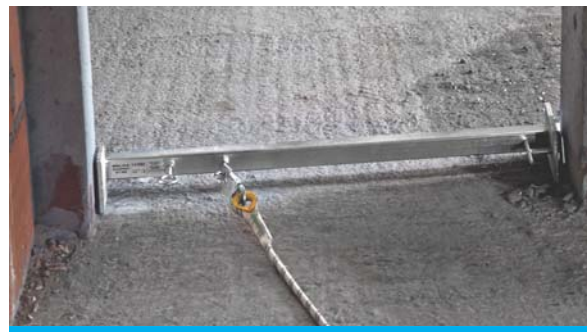
Kotwienie do belki poprzecznej mocowanej w otworach ściennych.
