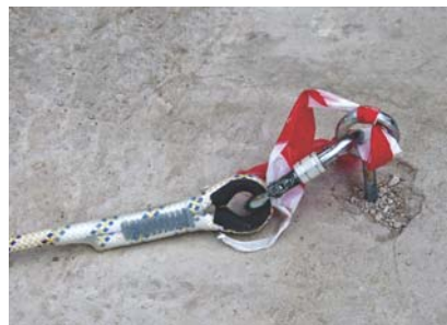
Kotew punktowa mocowana w betonie.
