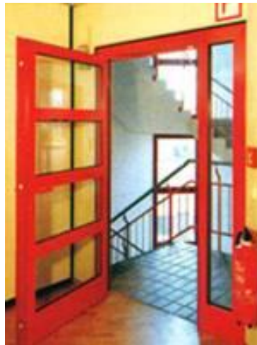
Drzwi ewakuacyjne prowadzące na klatkę schodową.
